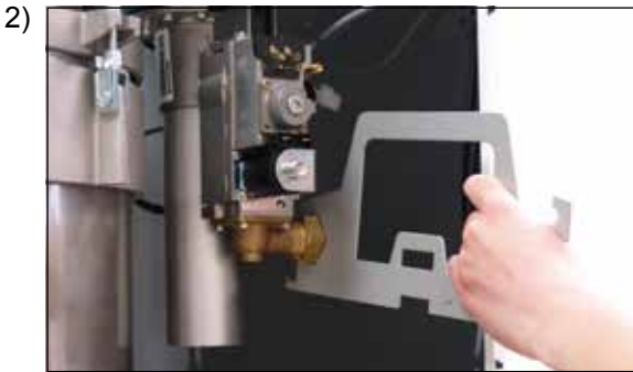
Løsn gastilslutning ved gasarmaturet
