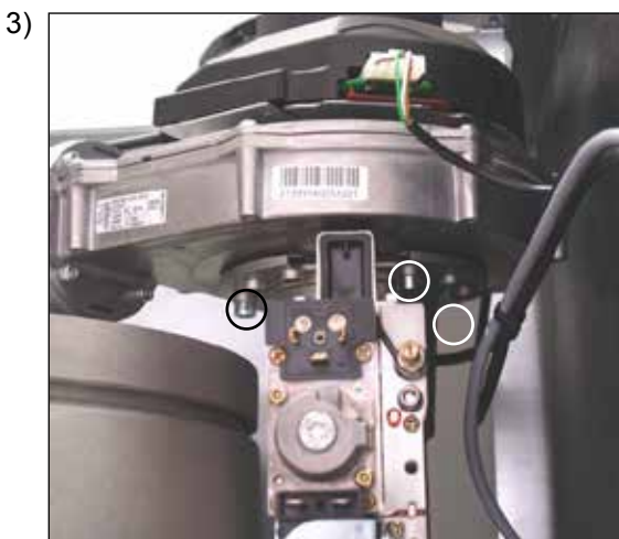
Odkręcić komorę mieszania od wentylatora (3 śruby inbusowe 5 mm), ewentualnie zdjąć rurę zasysania powietrza
