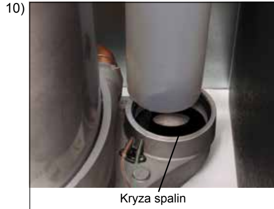
10) Kryzę spalin \varnothing 53 mm włożyć w wannę kondensatu i ponownie wsunąć rurę spalinową.
