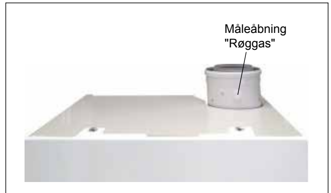
Billede: Røggasmåling ved lukket anlæg
