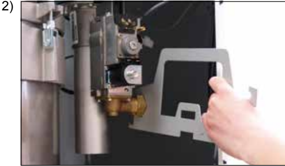
Gaz bağlantısının cıvatalarını gazlı kombi valfinden çözün
