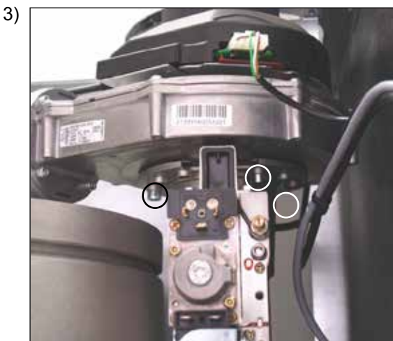
Skrue blandekammeret af ventilatoren (3 stk. unbracoskruer 5 mm) og træk evt. luftindtagsrøret af
