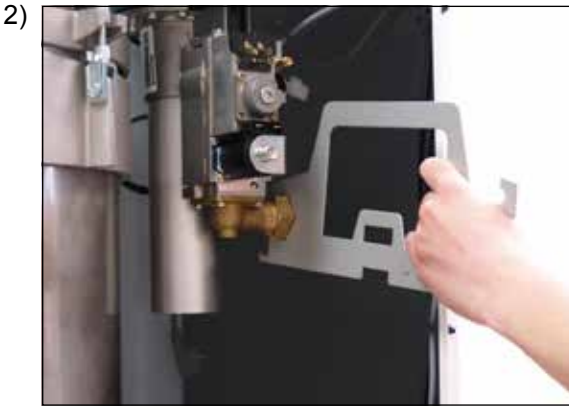
Gaz bağlantısının cıvatalarını gazlı kombi valfinden çözün
