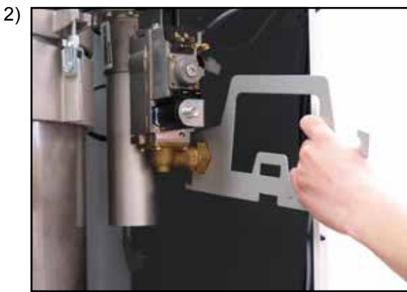
Poluzować złącze śrubowe przyłącza gazowego na zaworze gazowym
