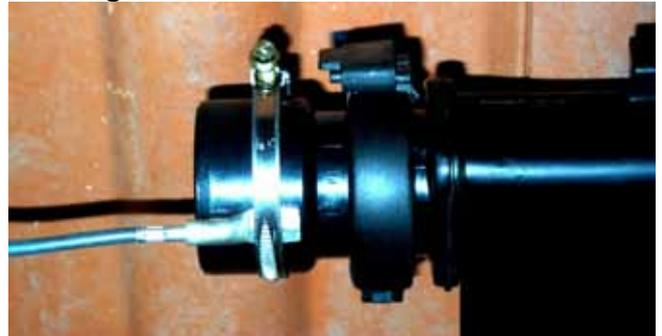
Nach dem Befestigen muss der Anlegefühler gedämmt werden!
