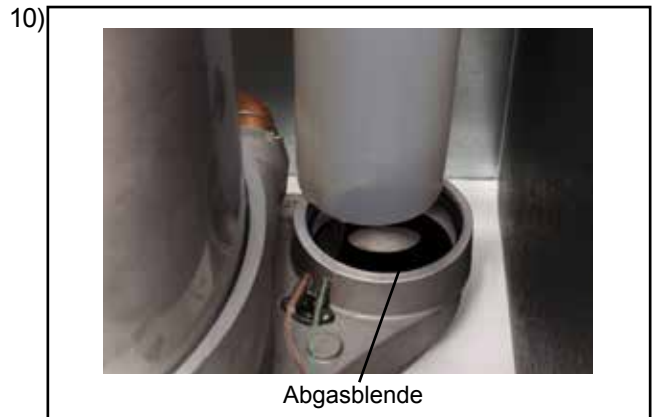
10) Abgasblende Ø 53 mm in die Kondensatwanne einlegen und Abgasrohr wieder hineinschieben.
