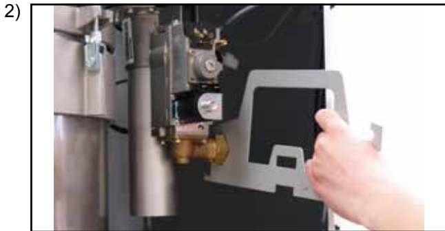
2) Verschraubung Gasanschluss am Gaskombiventil lösen
