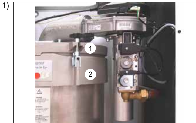
Stecker ①② abziehen (vorher Kreuzschlitzschrauben lösen)
