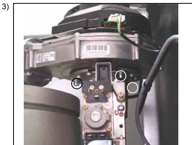
3) Mischkammer vom Ventilator (3 Stck. Innen-Sechskantschrauben 5mm) abschrauben evtl. Luftansaugrohr abziehen
