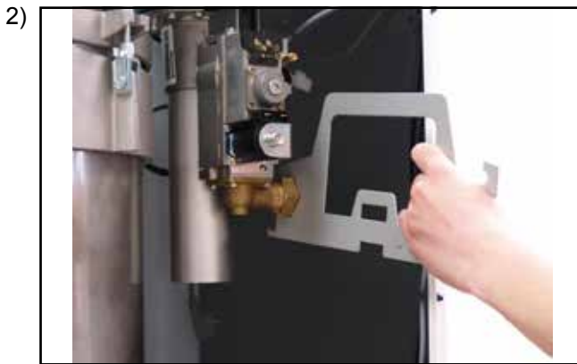
Verschraubung Gasanschluss am Gaskombiventil lösen
