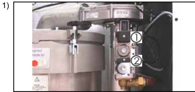
1) Stecker ①② abziehen (vorher Kreuzschlitzschrauben lösen)
