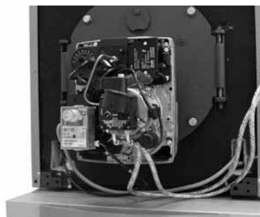
Kabelverlegung Brenner - Kessel
